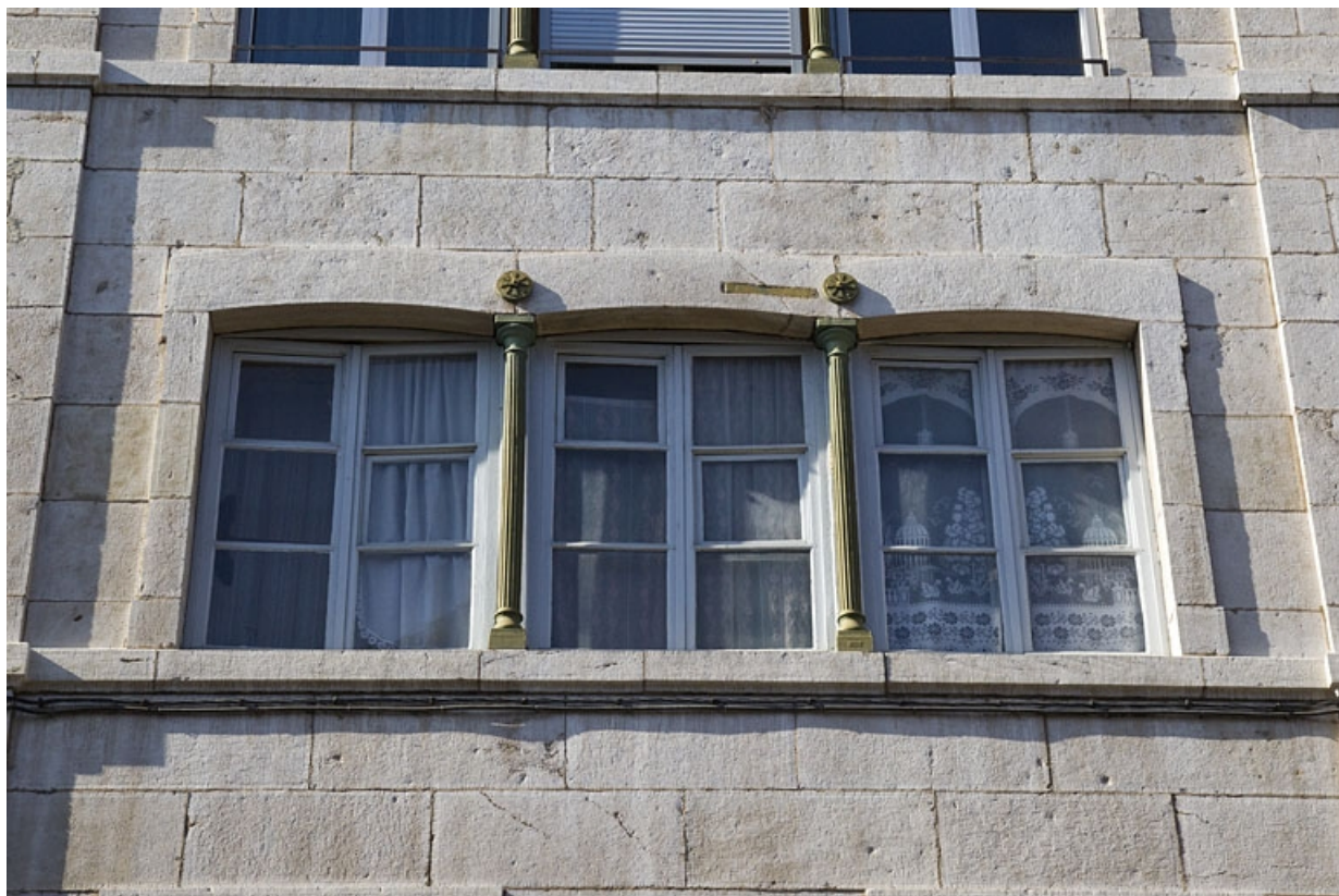
Détail d'une baie horlogère du premier étage.
