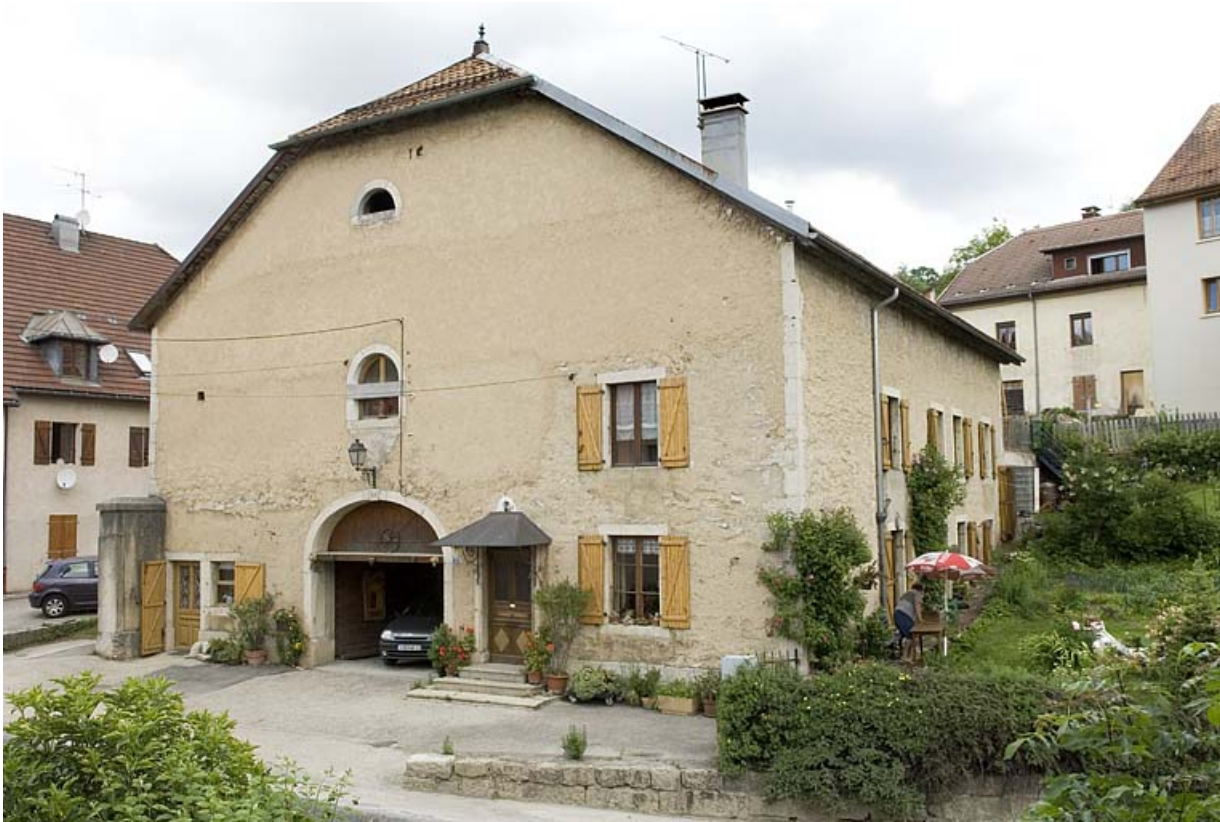
Façade antérieure, route des Alpes.
