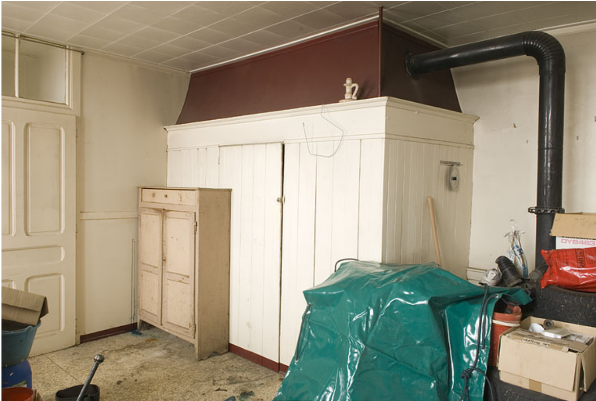
Cuisine au rez-de-chaussée : cheminée transformée en fumoir.
