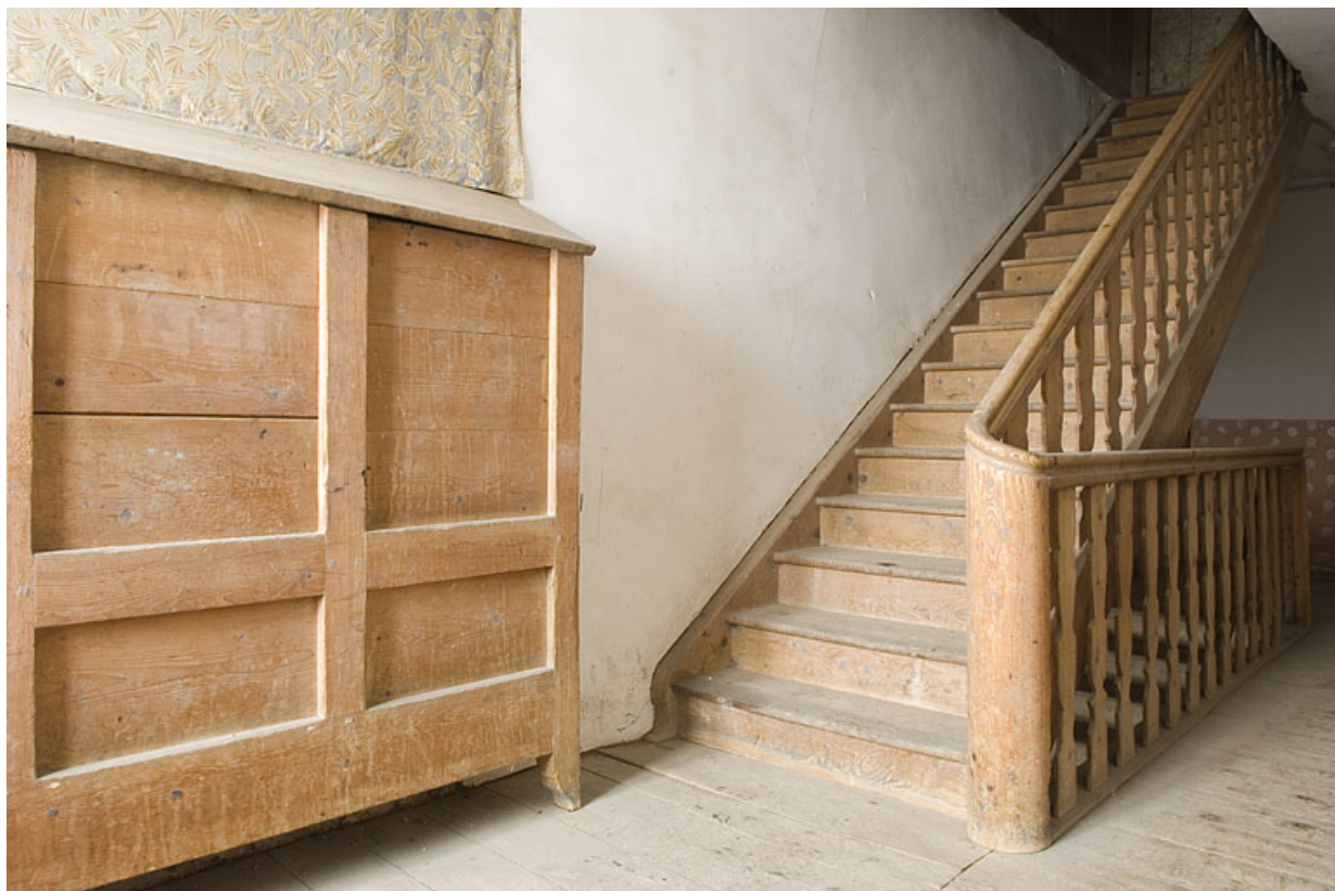
Escalier et coffre à grains.
