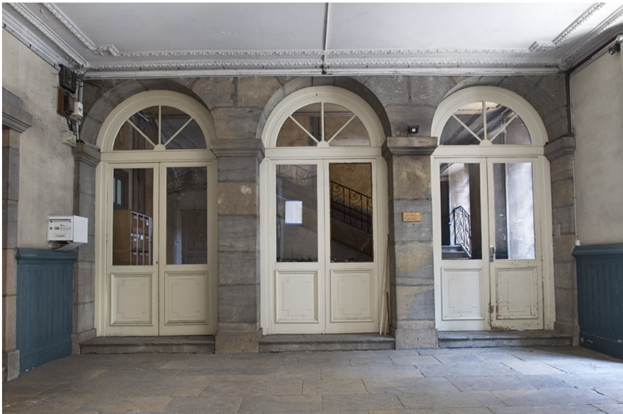
Vue de l'entrée de l'escalier, de face.
