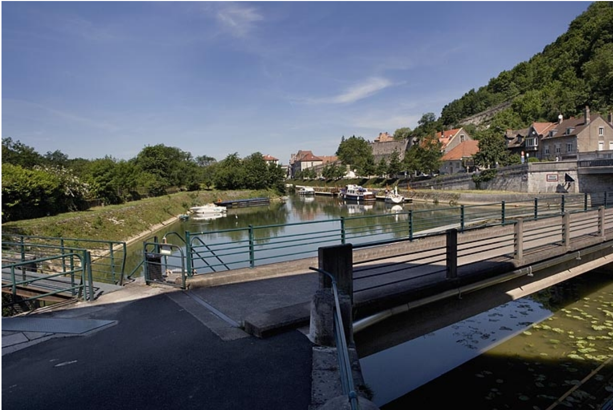
Vue d'ensemble depuis l'écluse n° 51.
