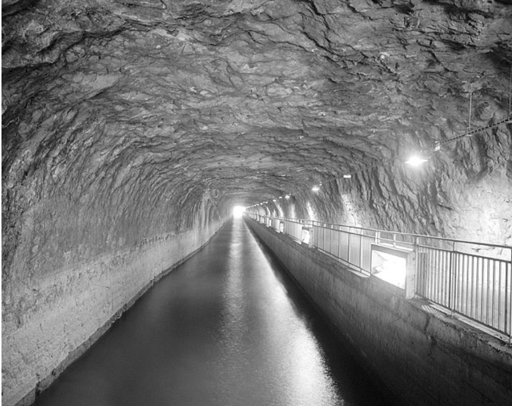
Intérieur, depuis la tête aval.
