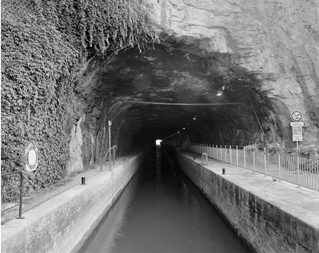
Sas de l'écluse, depuis l'aval.
