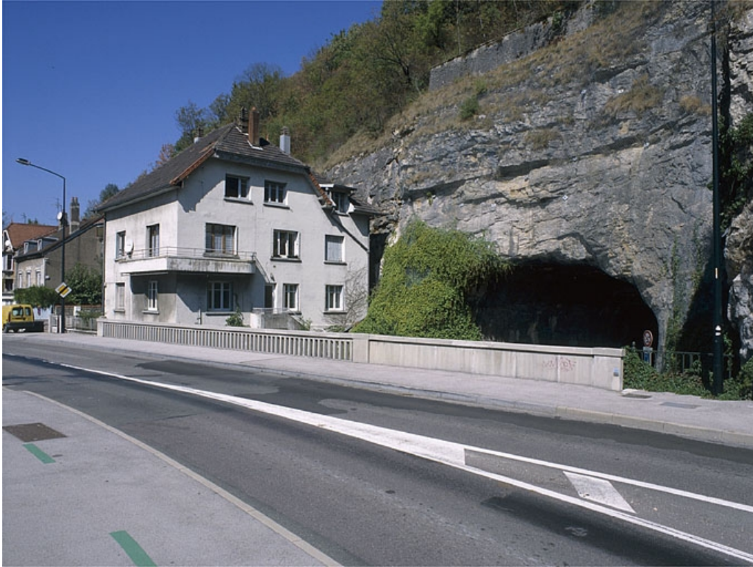
Pont routier et maison d'éclusier.
