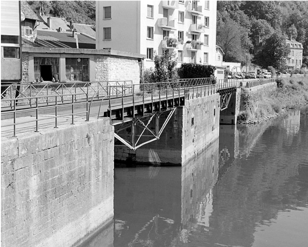
Ponts de halage sur les canaux de fuite de l'usine.
