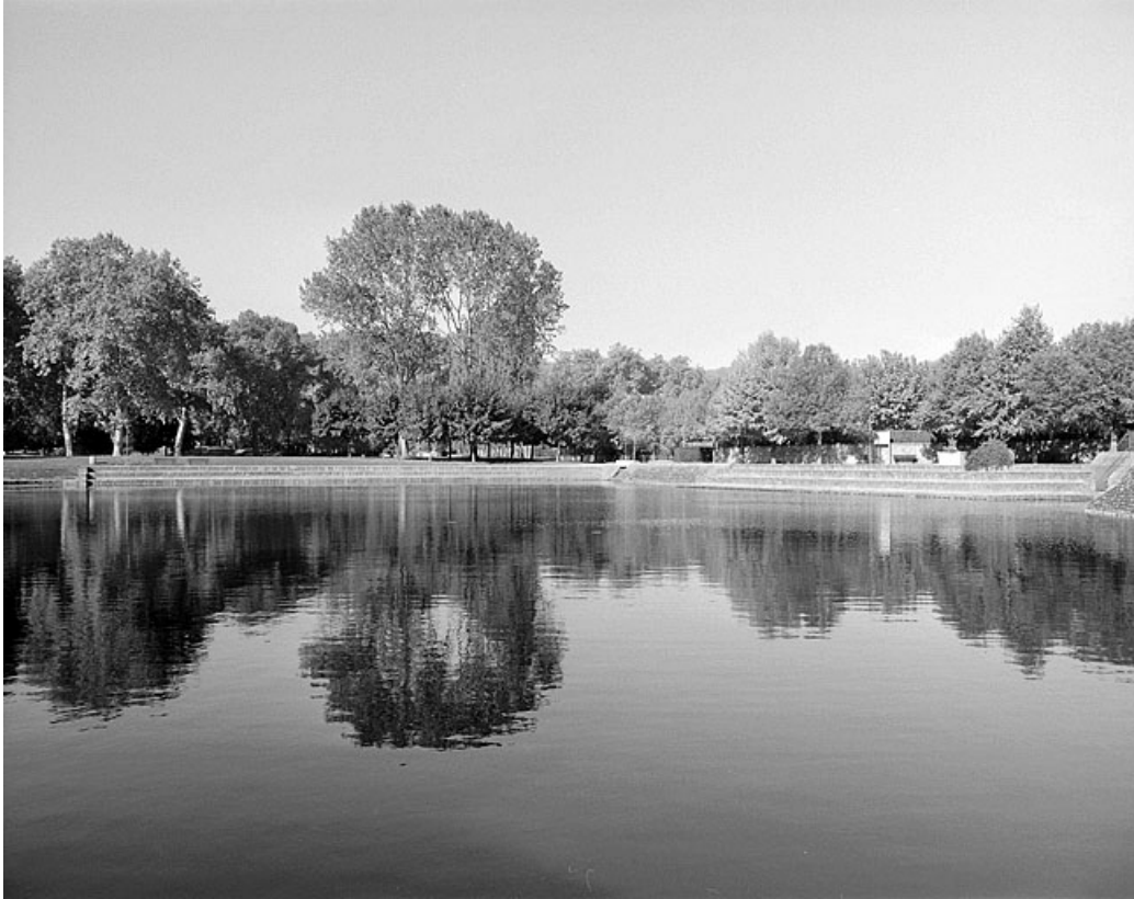
Le bassin depuis le chenal, au sud-est.
