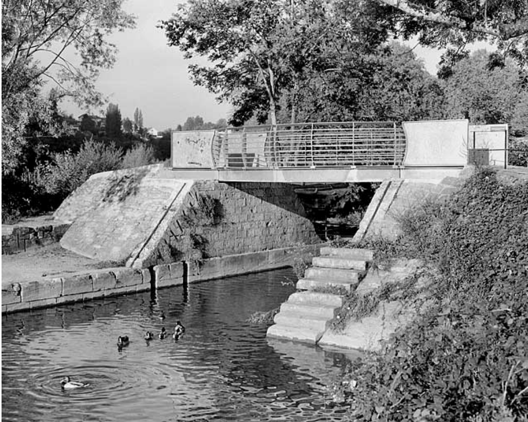
Passerelle de halage, depuis l'aval.
