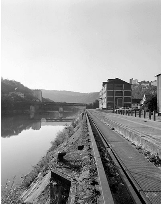
Entrepôt et quai, depuis l'aval.
