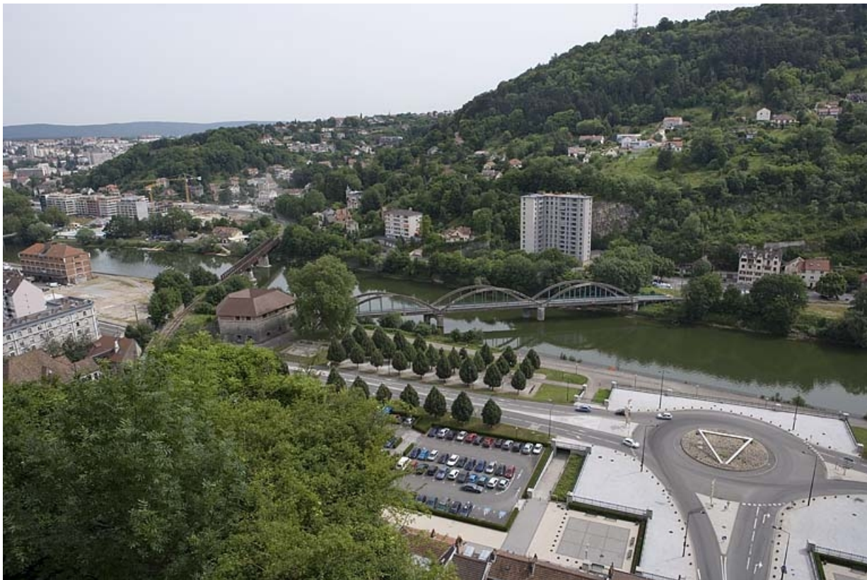
Vue d'ensemble plongeante sur la partie nord.
