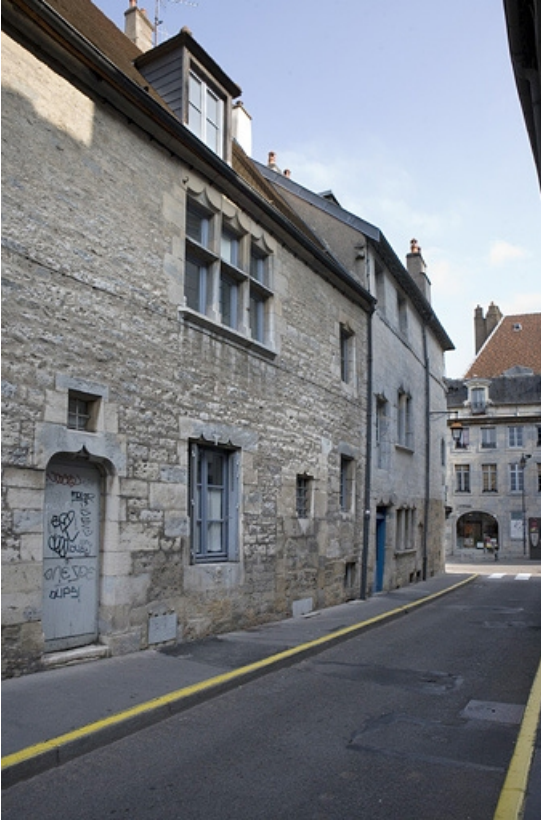
Façade latérale gauche : vue partielle.
