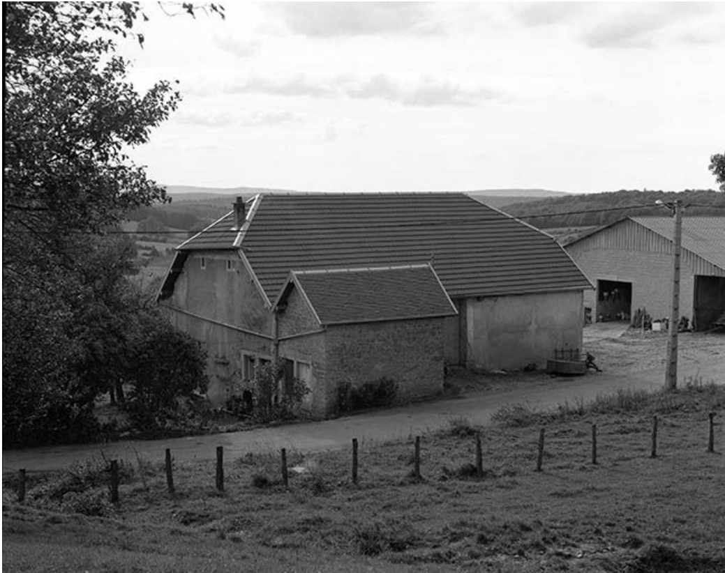
Façade antérieure et face latérale droite. 25, Malbrans
