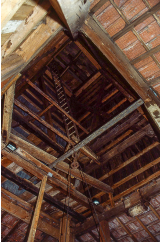
Puits de sondage nord : intérieur
