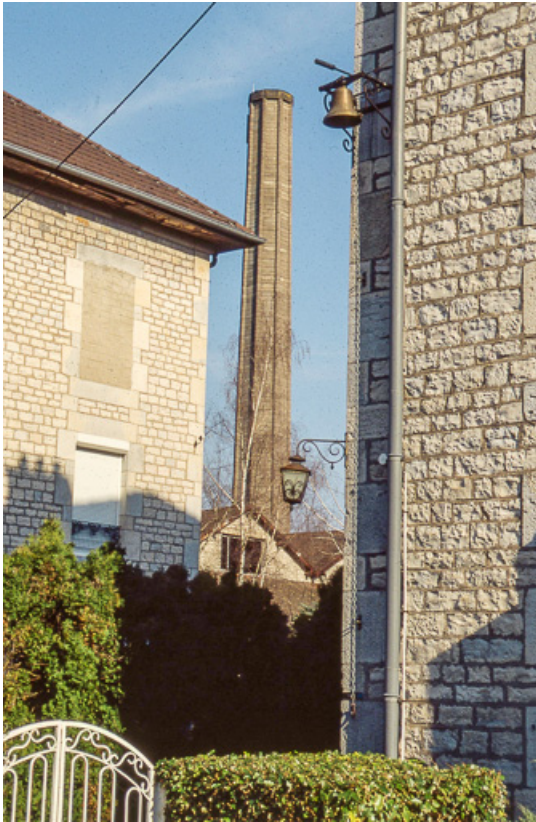
Bureaux, logements et cheminée.
