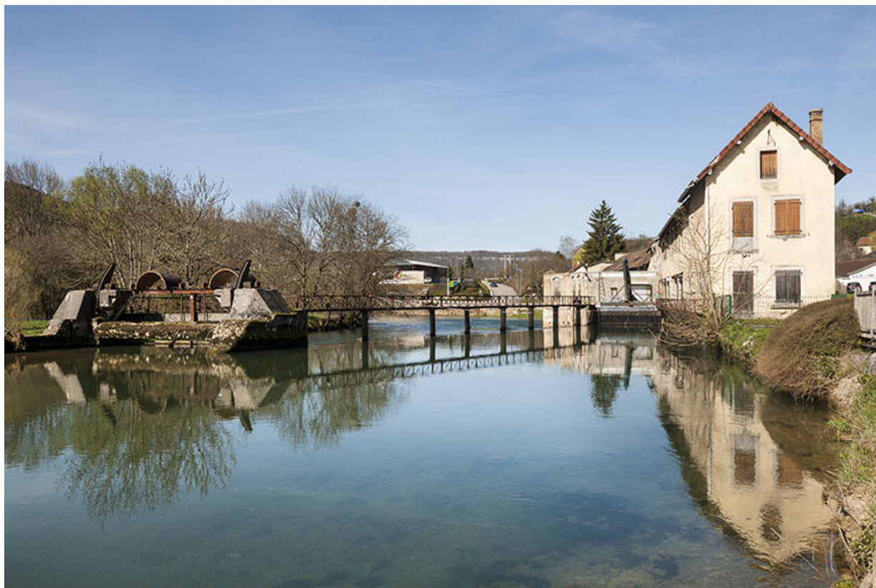
Vue depuis l'amont.
