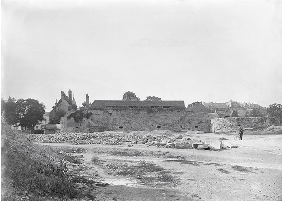
Démolition du château. [1890-1897].
