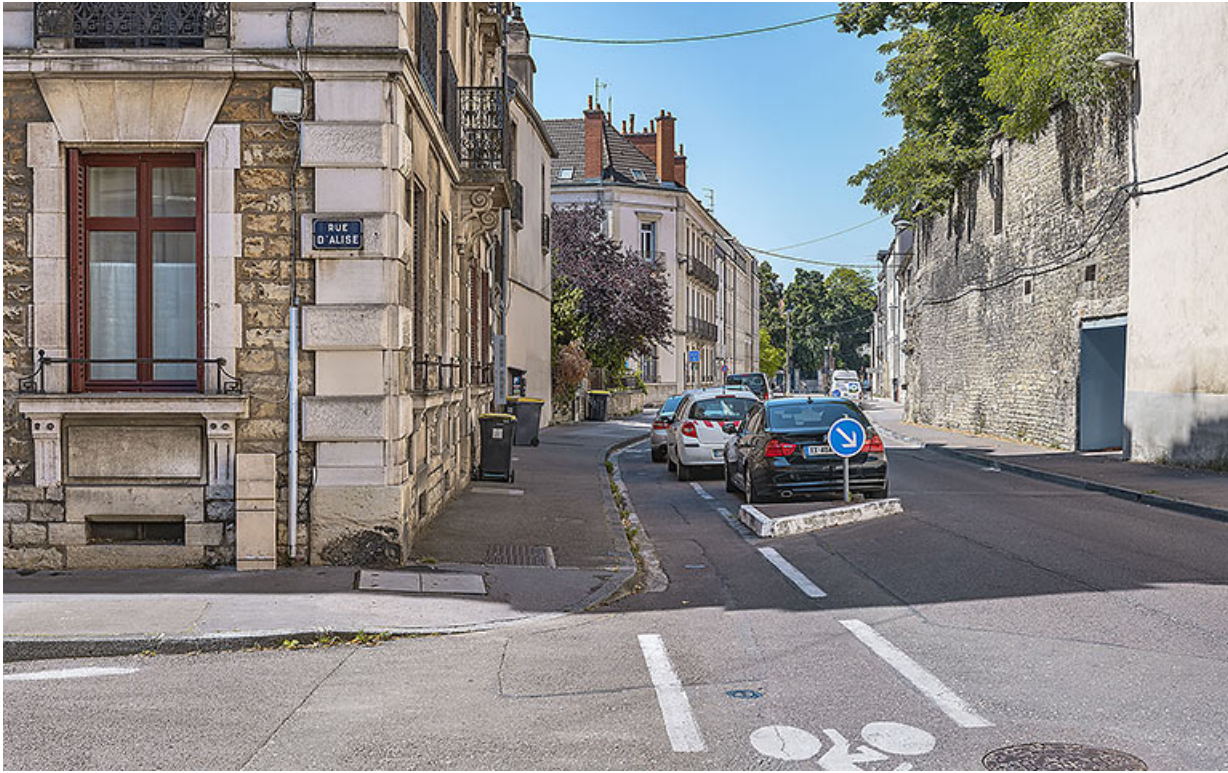
Le rempart (1er tronçon), rue Berlier. 21, Dijon
