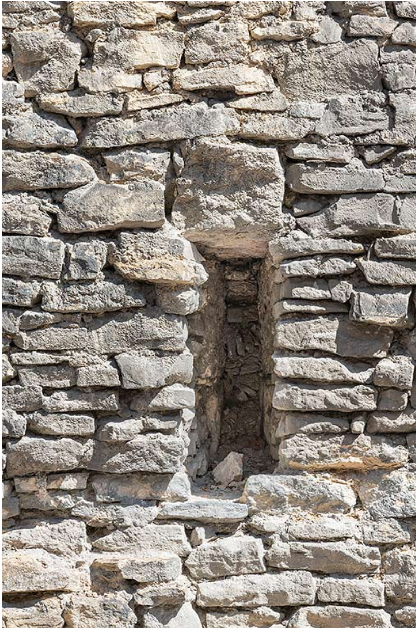
Détail d'une meurtrière, rue de Tivoli.
