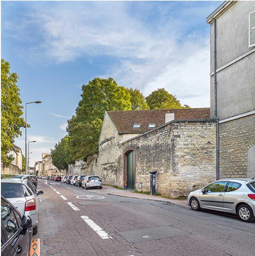
Portion du rempart, rue Diderot. 21, Dijon
