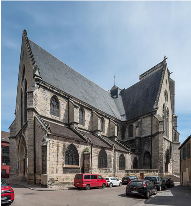
Façade sud, de trois quarts gauche.
