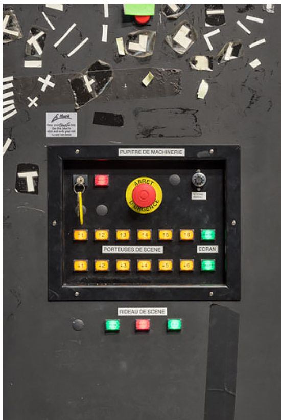
Pupitre de commande de la machinerie.
