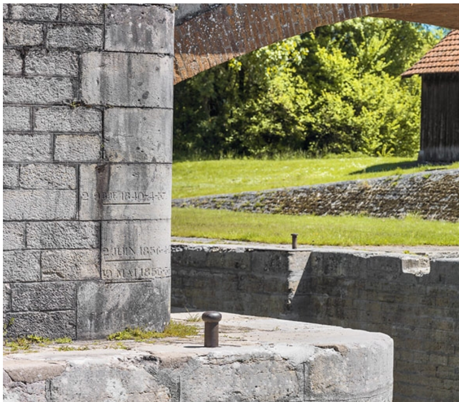
Détail de l'échelle de crue.
