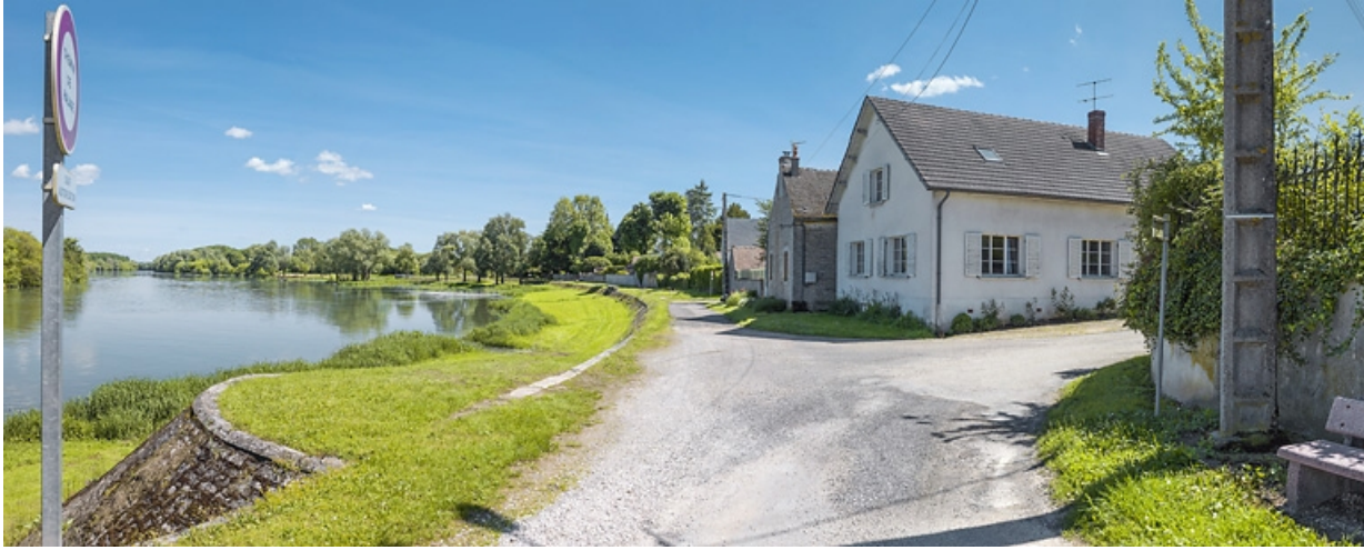
Tête aval de la digue.
