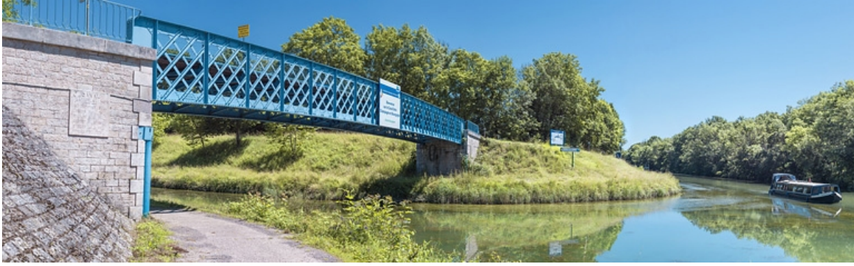
Vue d'ensemble. A droite, la dérivation d'Heuilley.
