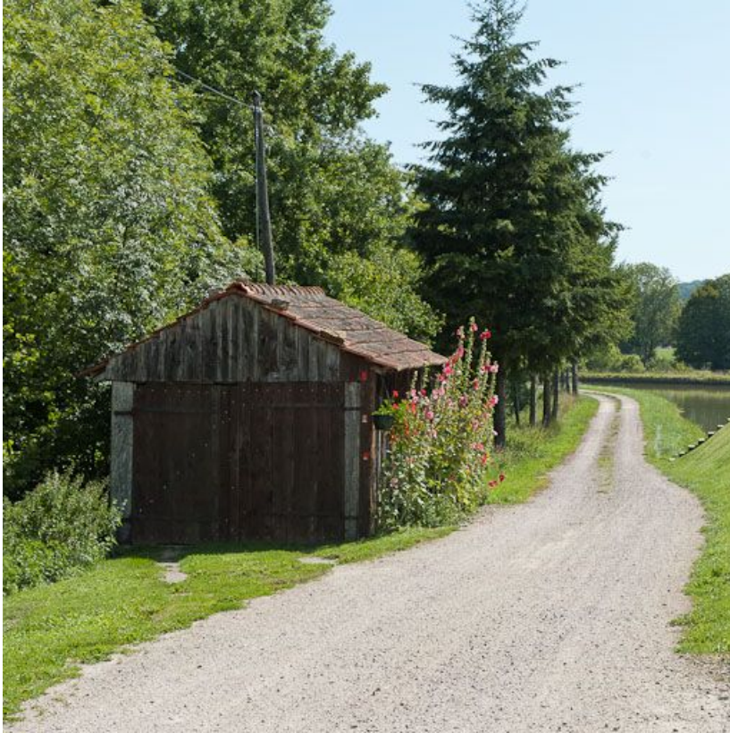
Vue de la remise en bois.
