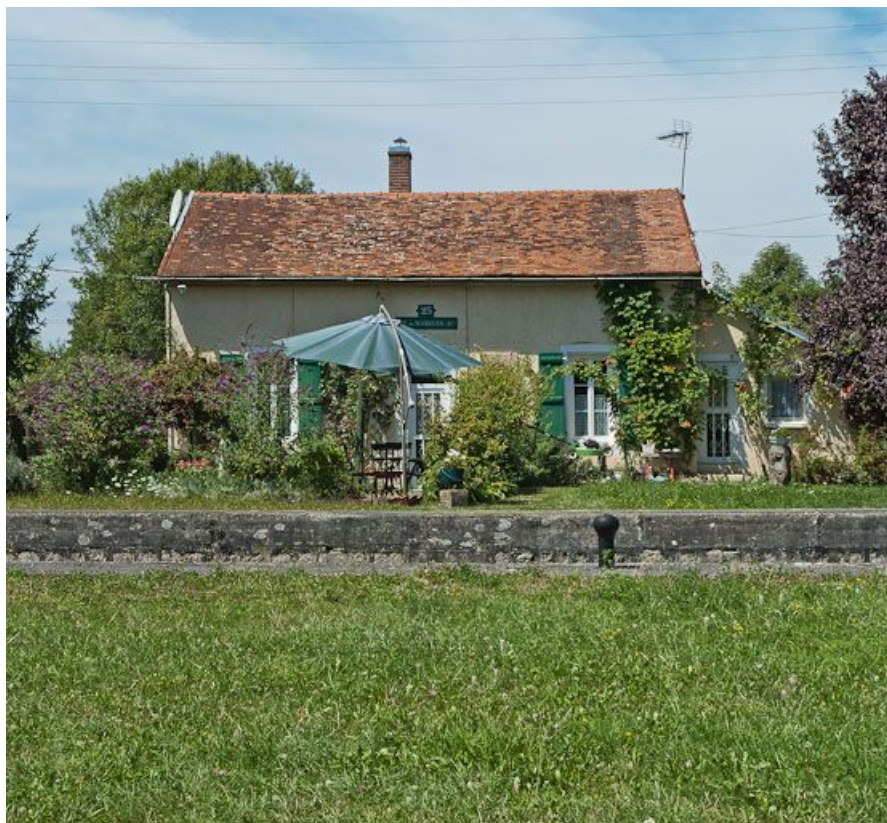
Vue de face de la maison éclusière.
