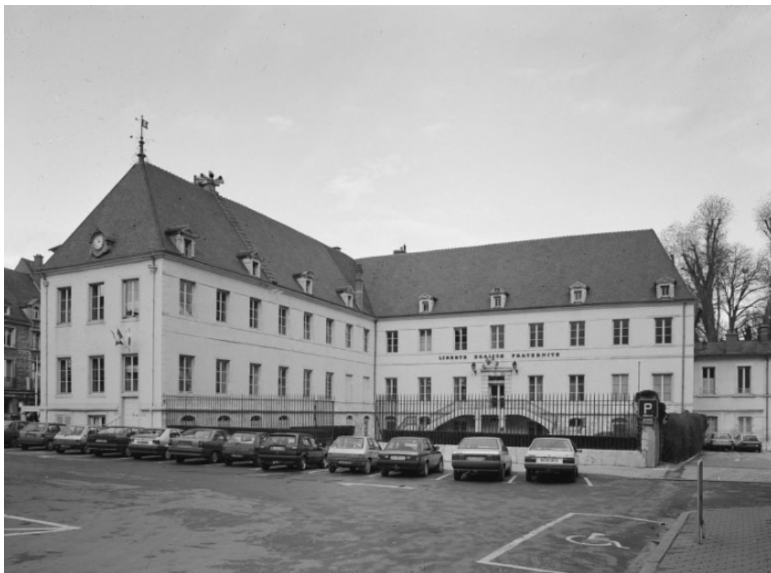
Elévations antérieure et latérale en 1996.
