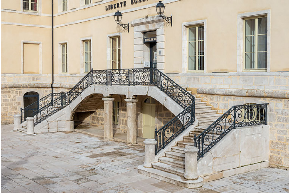
Aile est, façade antérieure : escalier.
