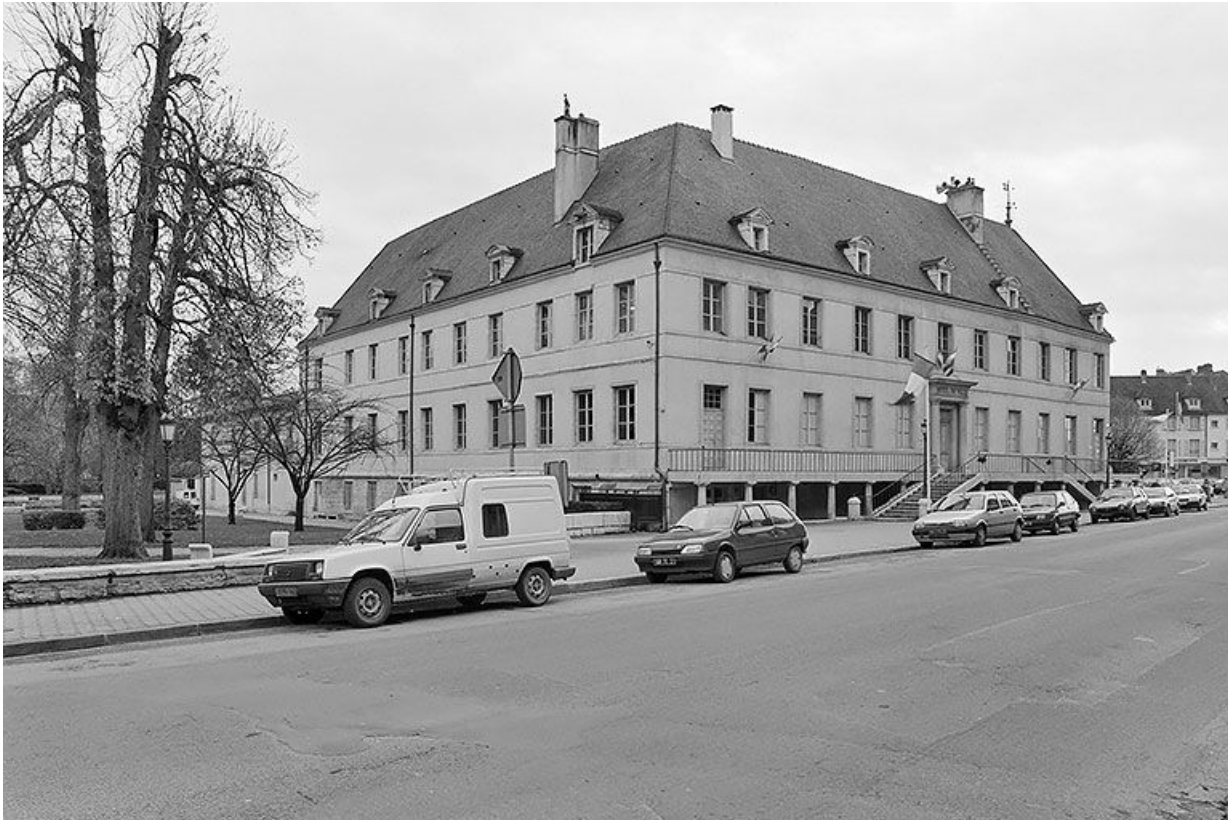
Elévations postérieure et latérale en 1996.
