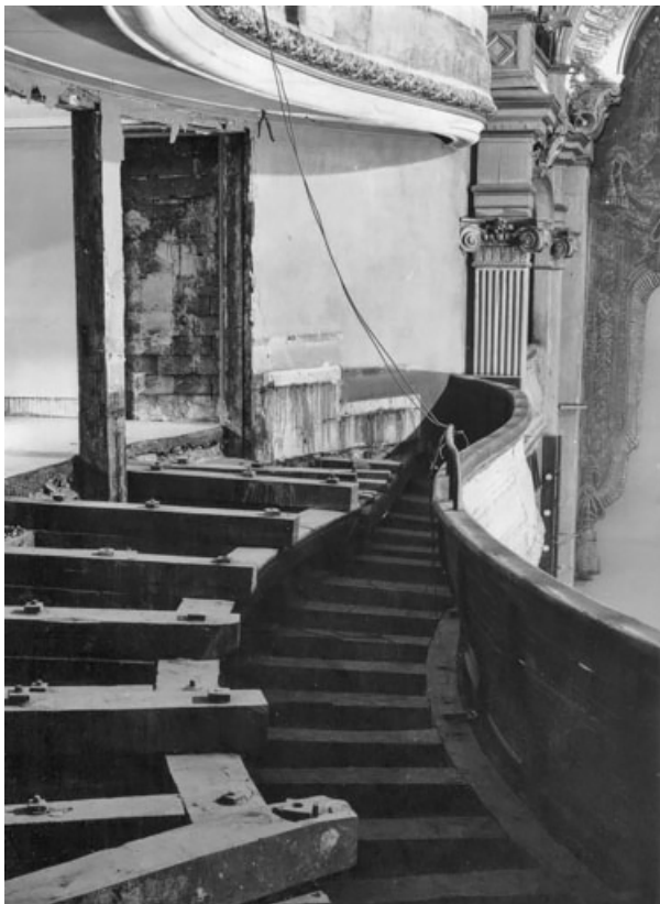
2ème galerie - ossature côté scène [pendant les travaux]. S.d. [1970]. 21, Dijon place du Théâtre
