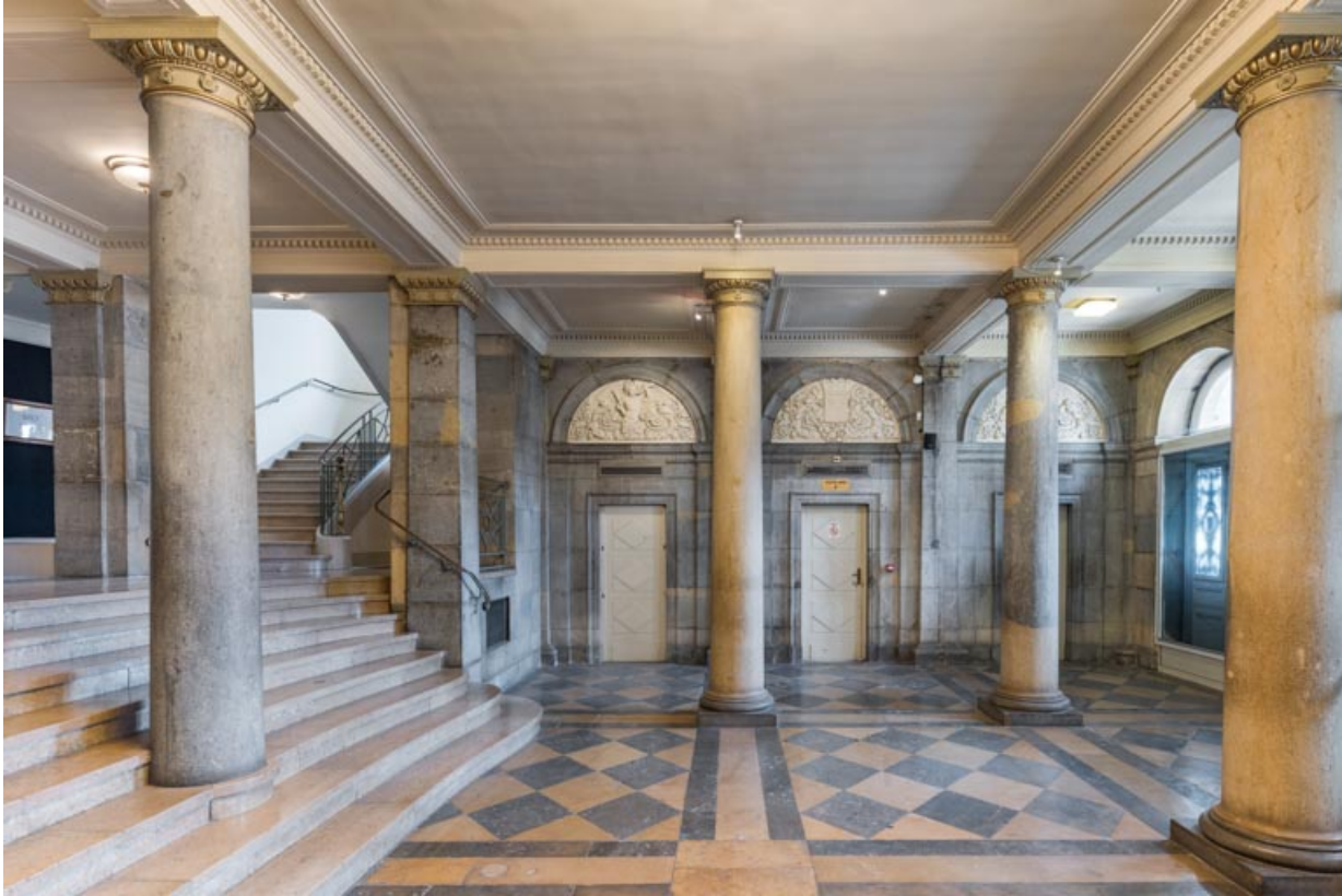
Vestibule : mur latéral droite.
