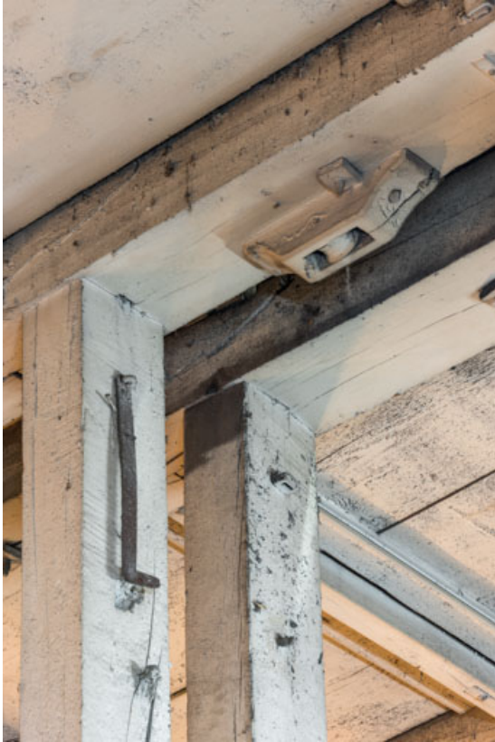
2e dessous : charpente soutenant le plancher du 1er dessous, au niveau d'une costière. 21, Dijon place du Théâtre
