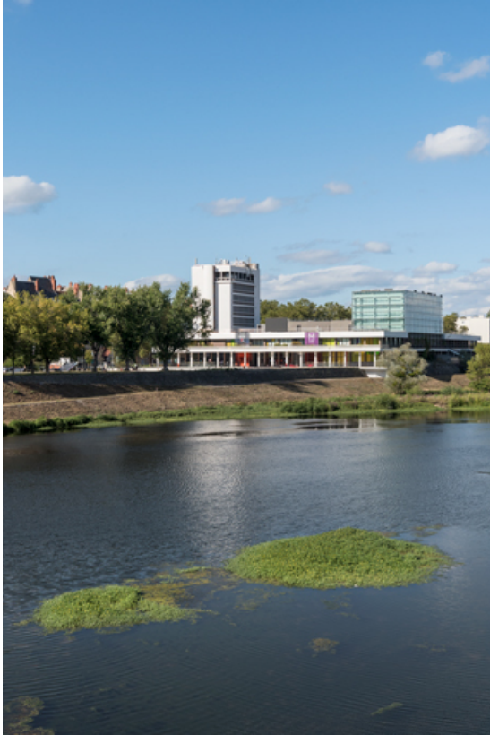
Vue d'ensemble, depuis le sud (cadrage vertical).
