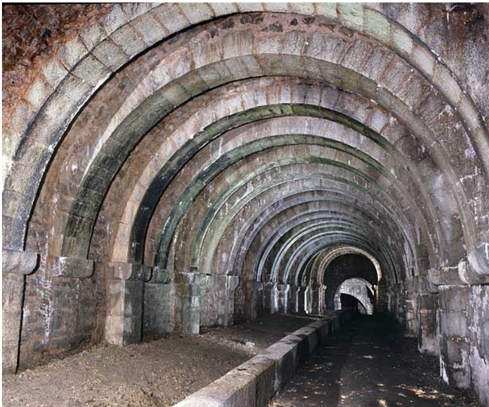
Galerie souterraine voûtée.
