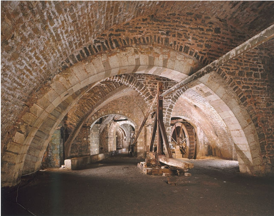
La mécanique hydraulique du puits d'Amont.
