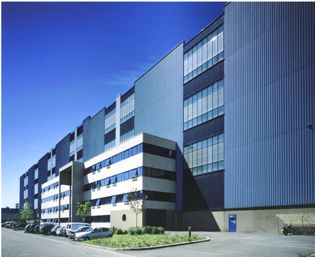
Halle 330 (bureaux et ateliers de montage).
