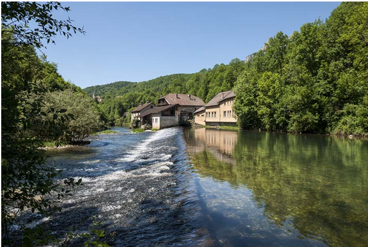
Vue d'ensemble depuis le barrage, en amont.
