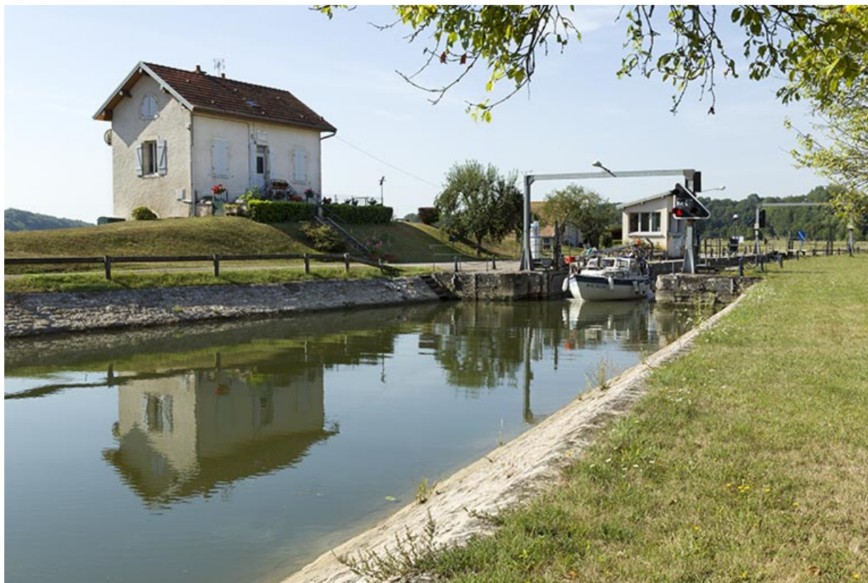
Vue amont du site d'écluse.
