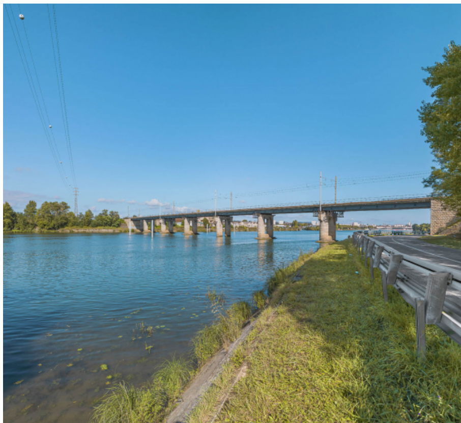
Le pont vu d'aval, rive gauche.
