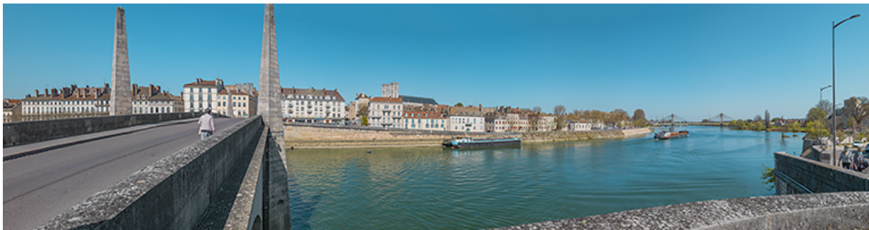
Le pont Saint-Laurent de Chalon-sur-Saône (71).
