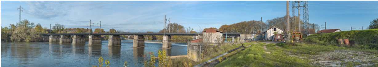
Le pont ferroviaire d'Auxonne (21).
