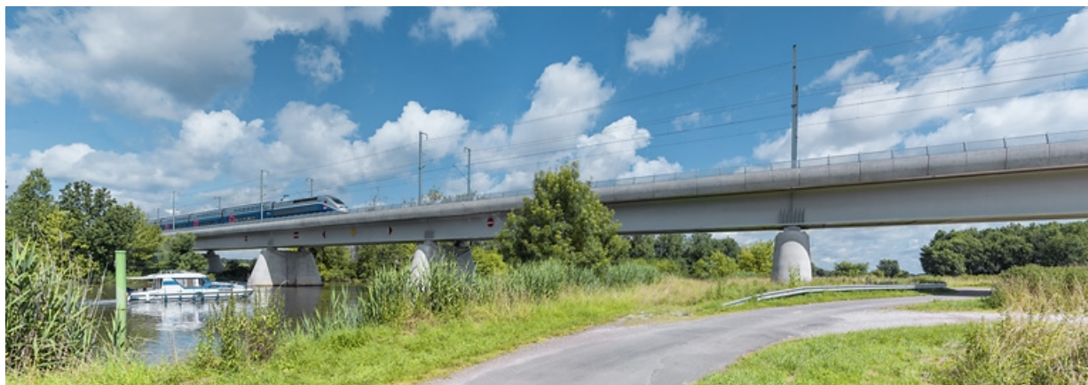
Vue d'ensemble avec TGV franchissant la Saône.
