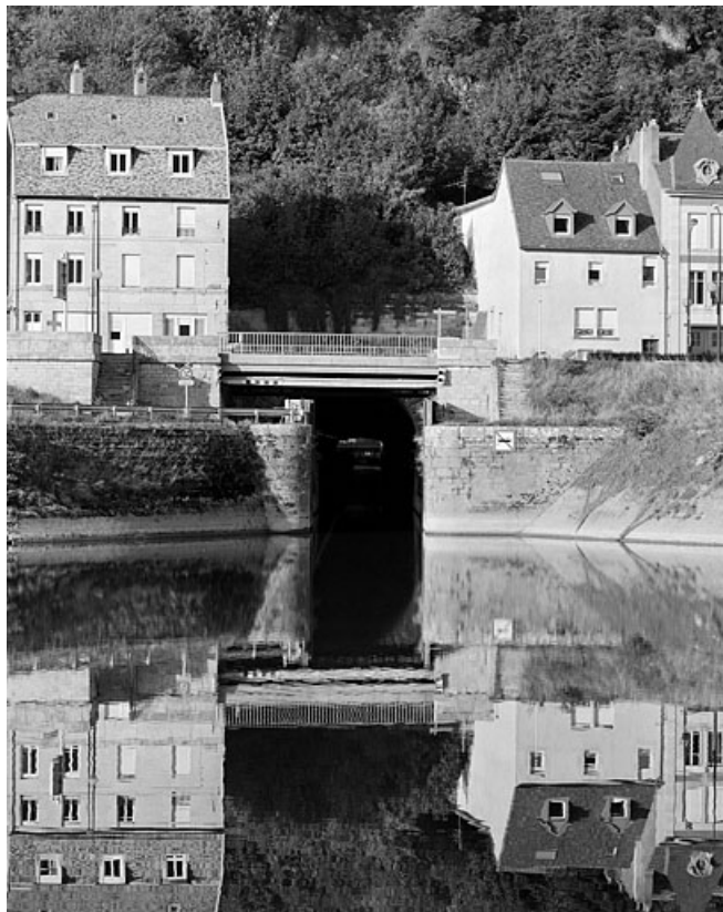
Porte de garde et extrémité amont.
