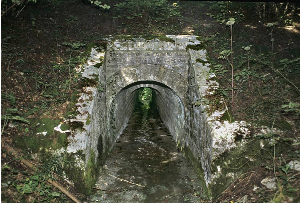
Tête amont (avec éclairage au flash).
