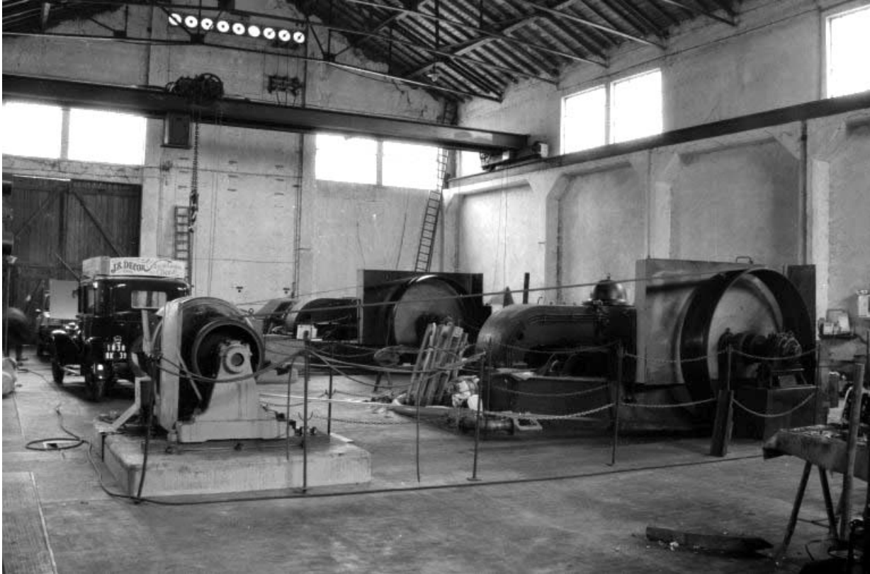
Centrale hydroélectrique, intérieur : transmission de la turbine et alternateur. 39, Audelange, lieudit : au Moulin d'Audelange
