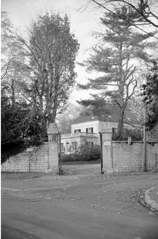
Entrée du Clos de Belvoye.
