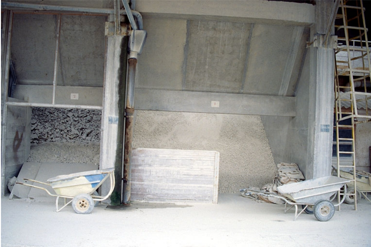
Hangar à terre (18) : détail des silos ouverts.
