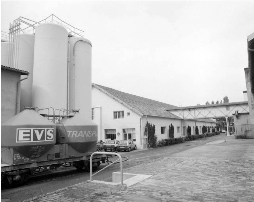
Façades postérieure et latérale gauche des bureaux.
