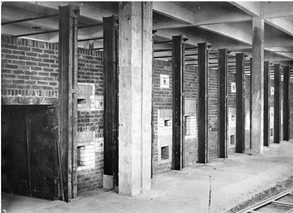
Four Dressler en construction : vue latérale.
