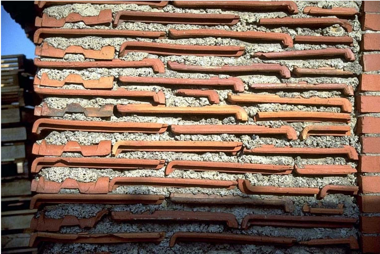
Atelier de fabrication : tuiles en gros oeuvre.
