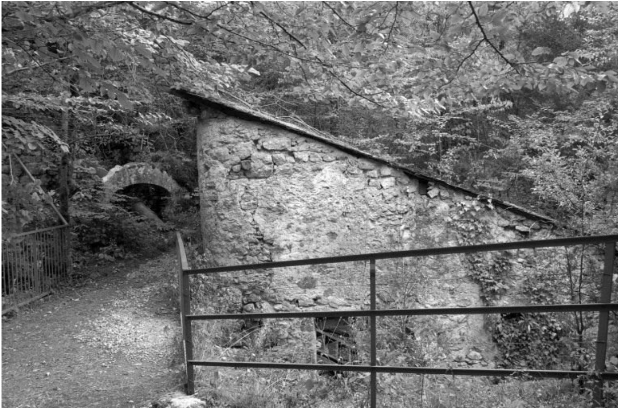
Site de la cascade : bâtiment d'eau.
