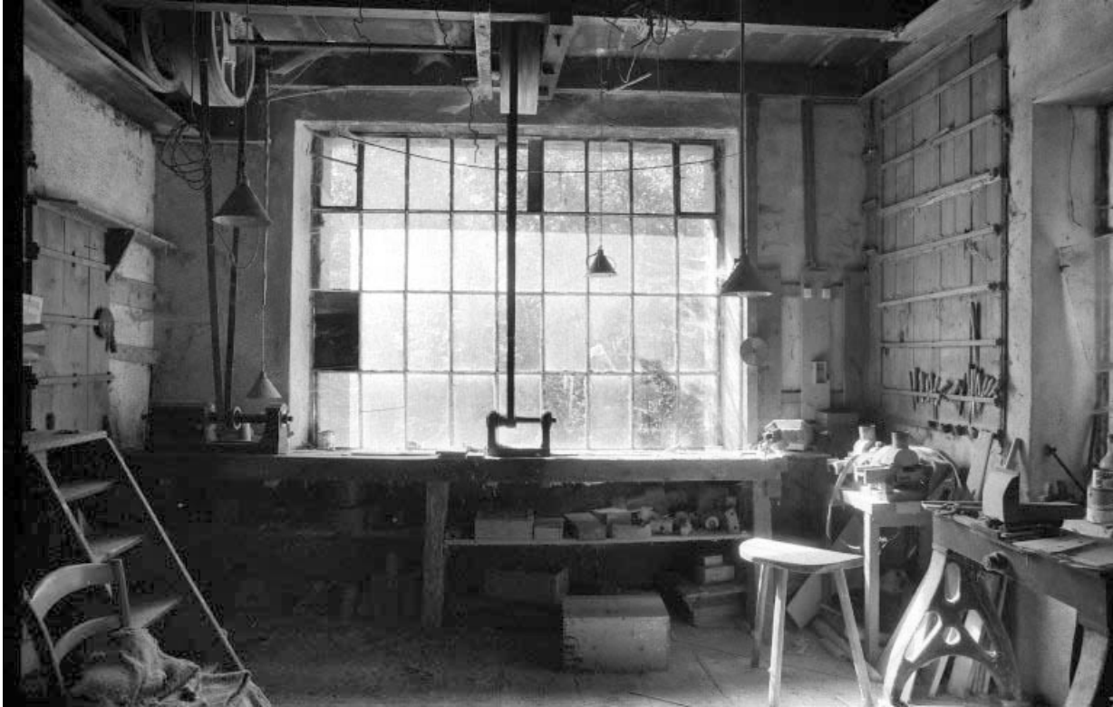
Intérieur d'un atelier de fabrication (bâtiment E).
