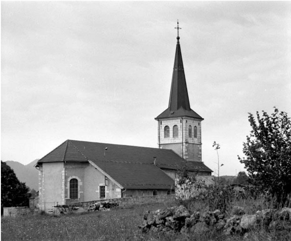
Extérieur : vue générale depuis le nord-est.
