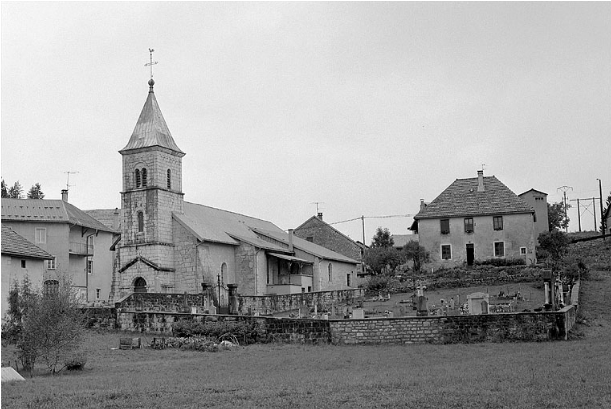
Extérieur : vue générale depuis le sud-ouest.
