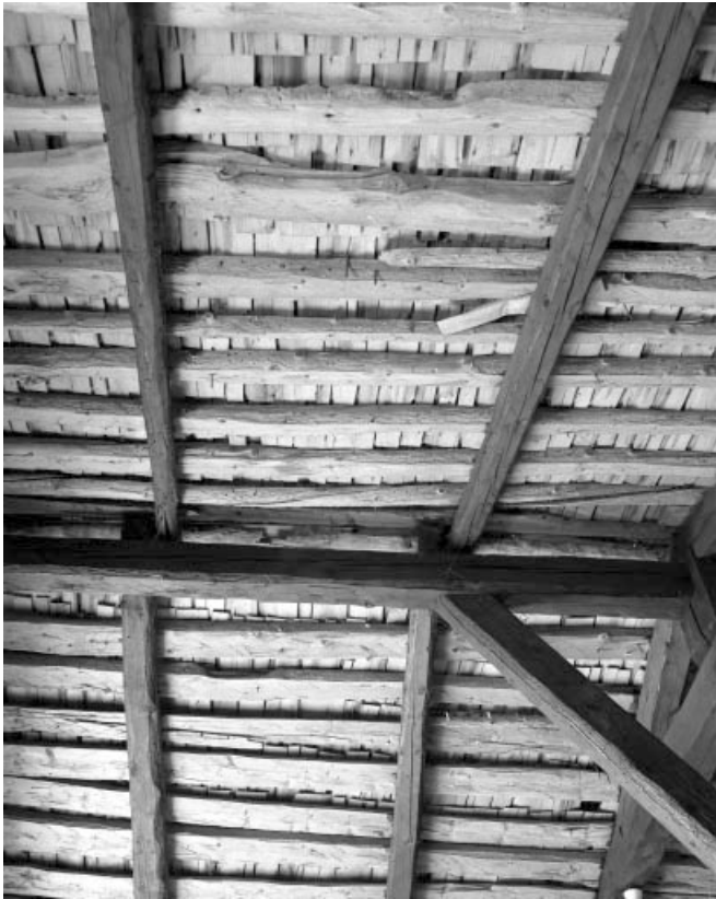
Détail de la couverture depuis la grange haute : les tavillons sont encore posés sous la couverture en tôle actuelle. 39, Les Moussières, lieudit : au Montechoux
