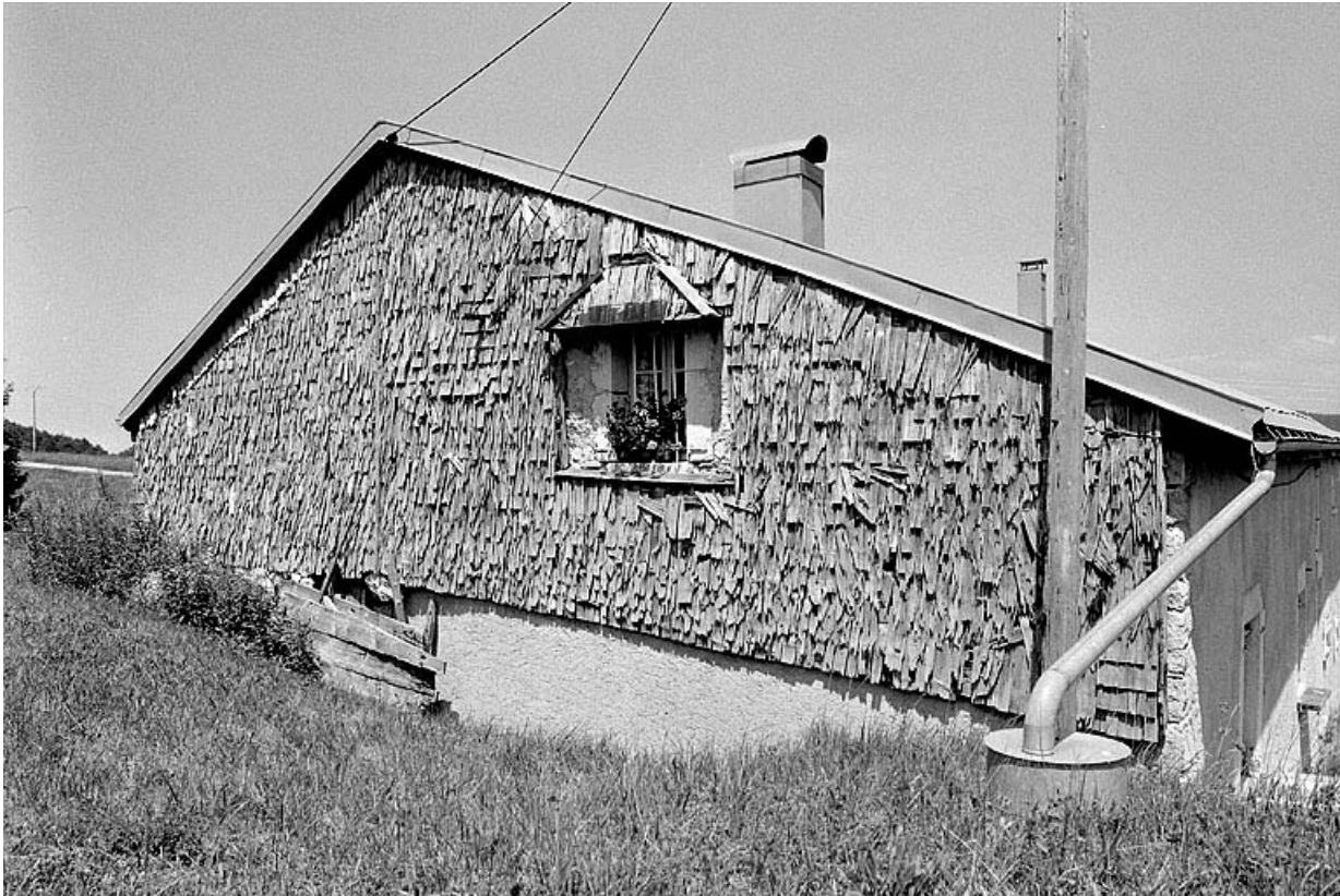
Face gauche couverte d'un essentage de tavaillons.
