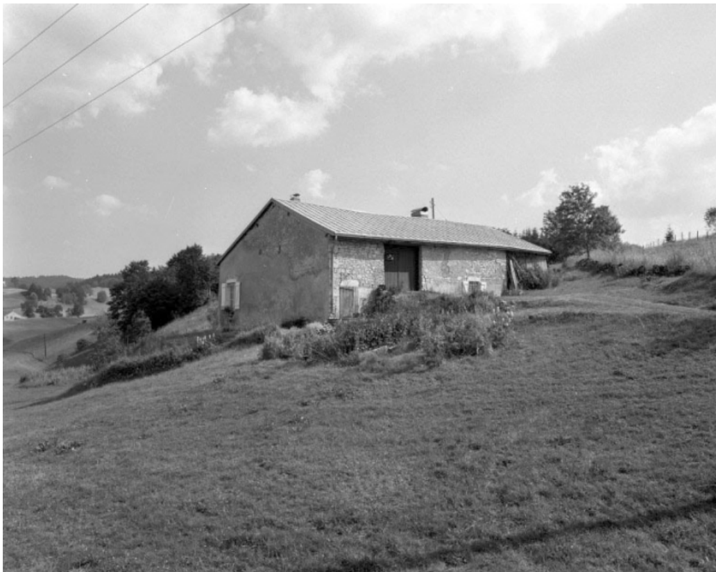
Face droite et façade postérieure.
