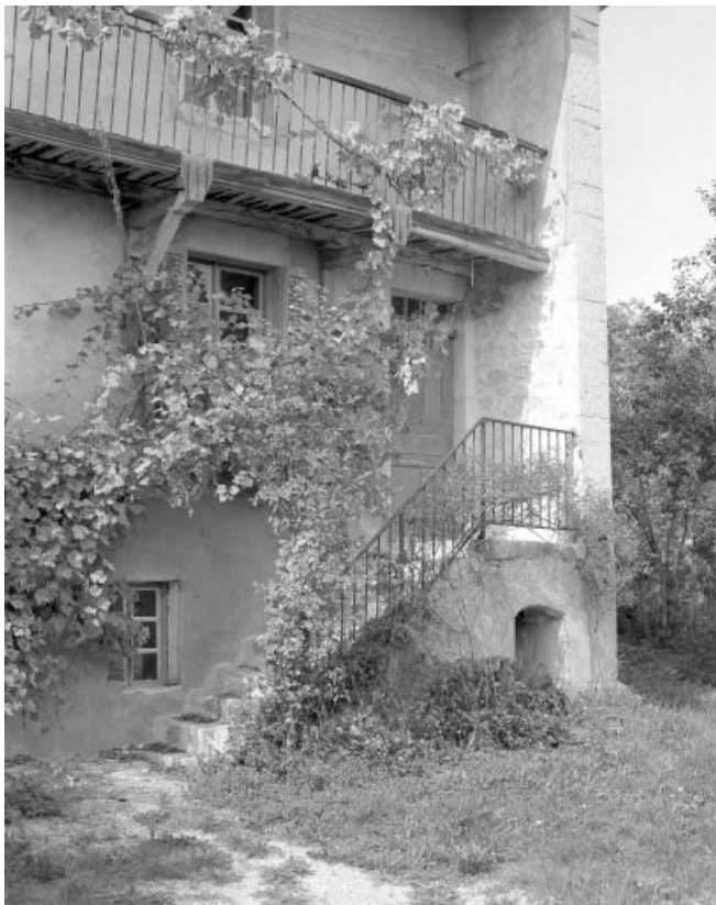
Façade antérieure, accès au logis de droite.
