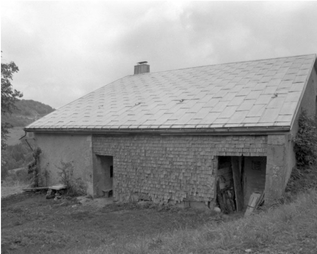
Façade antérieure avec galerie fermée en tavaillons.
