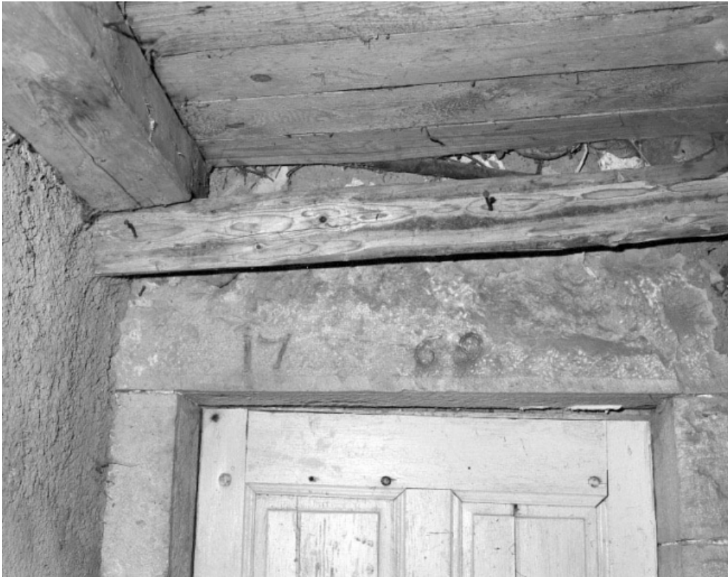
Porte d'accès au logis.
