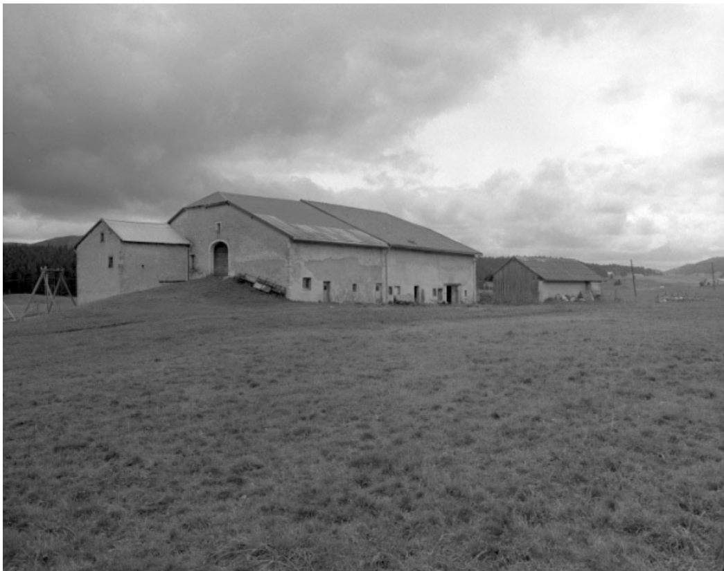
Façade postérieure des deux fermes mitoyennes.
