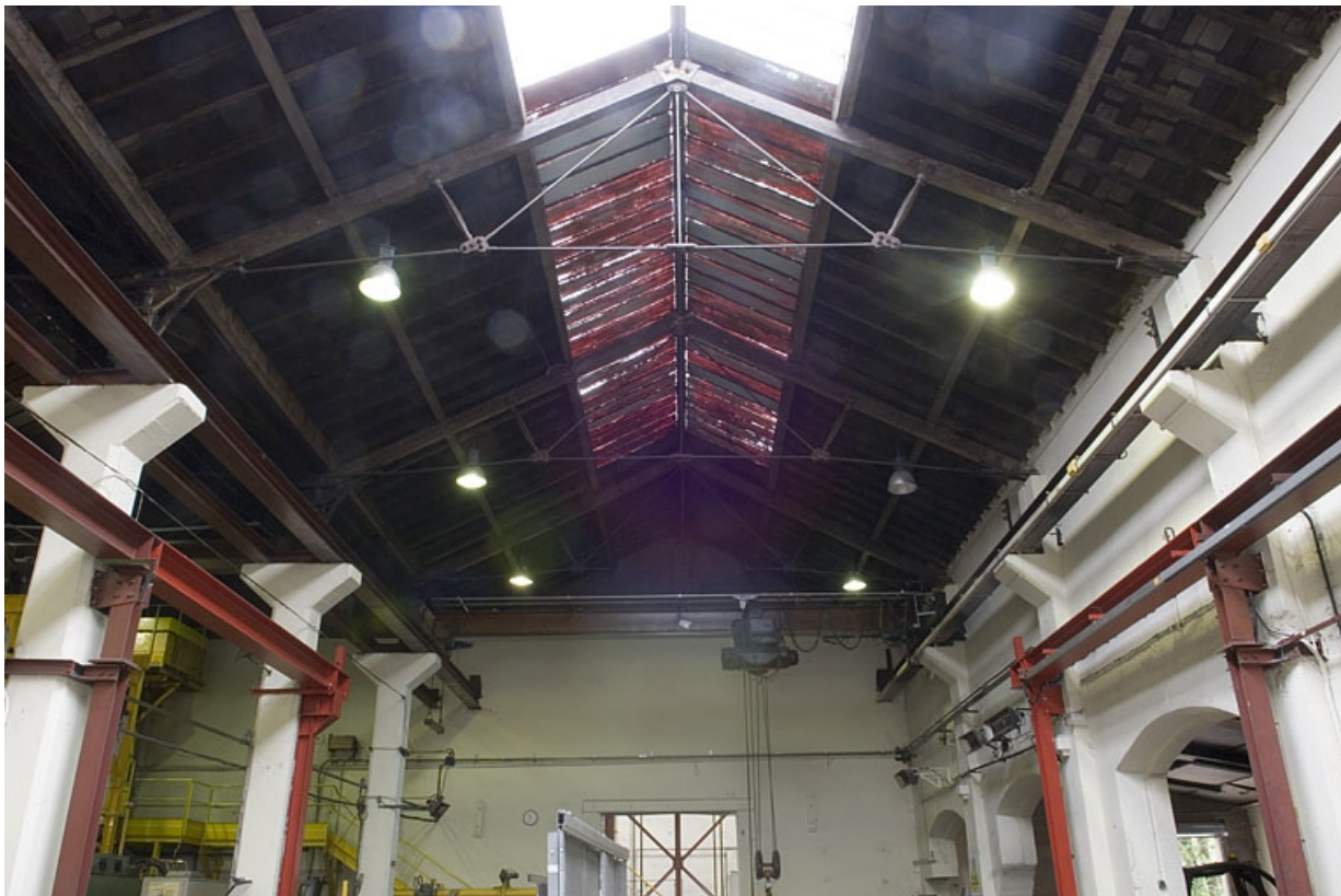
Intérieur de l'atelier et charpente Polonceau.
