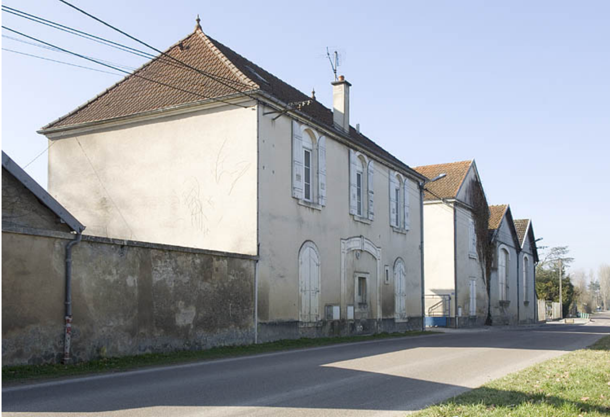
Vue d'ensemble depuis le quai Mavia.
