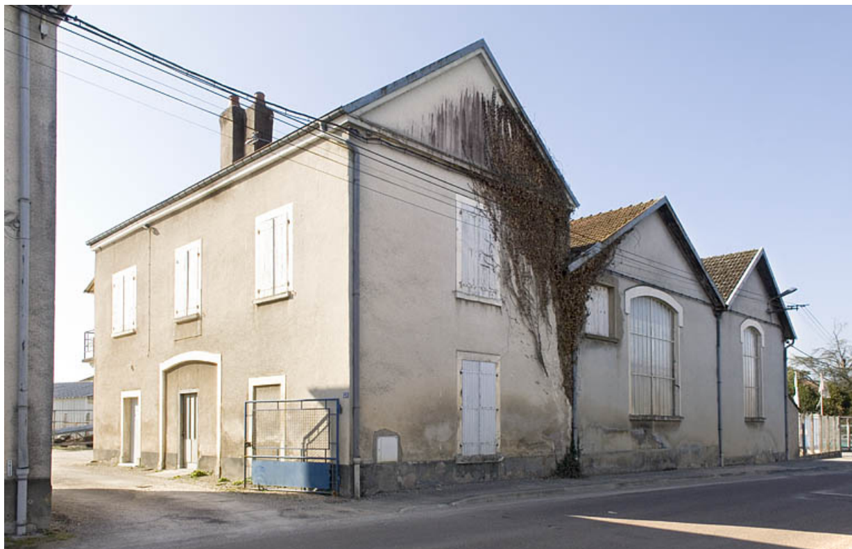
Bâtiments industriels. Logement, entrepôt et atelier.
