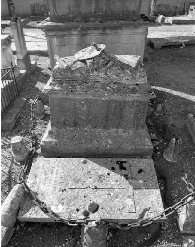
Façade droite, en plongée.
